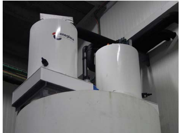
2 scherfijsgeneratoren F200SBF van Geneglace.
