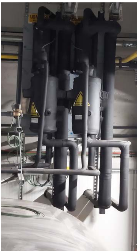
Platenwisselaar CO 2 -NH 3 +vloeistofvat NH 3 .
