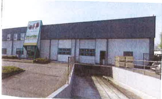
Het gebouw van De Winter natuurdarmen nv in Lokeren.
